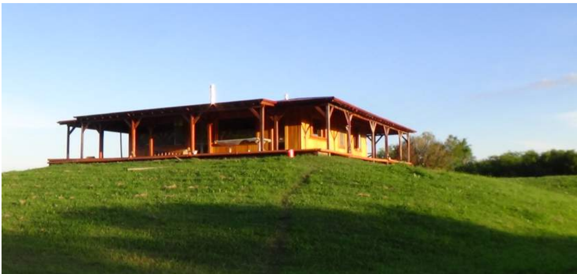
La vivienda está diseñada con techos inclinados y de chapa, para recoger el agua de lluvia sobre las canaletas perimetrales.
